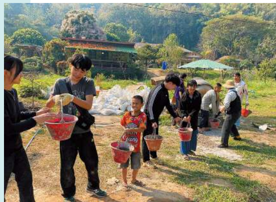
メーコック財団の子供たちとセメントをバケツリレーで運ぶ
